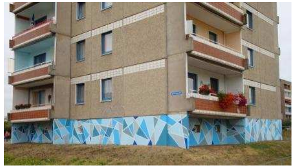
Abb. 25) Sockelgestaltung von Neubaublöcken in Schönebeck (Unterricht in einer 9. Klasse von Regine Söde und Katrin Hess)
